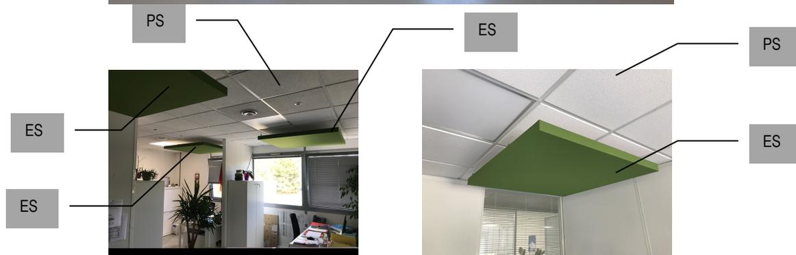
Plafond suspendu (PS) absorbant et éléments suspendus (ES) absorbants (suspendus à l'ossature existante) pour l'amélioration de la performance acoustique d'un bureau.
