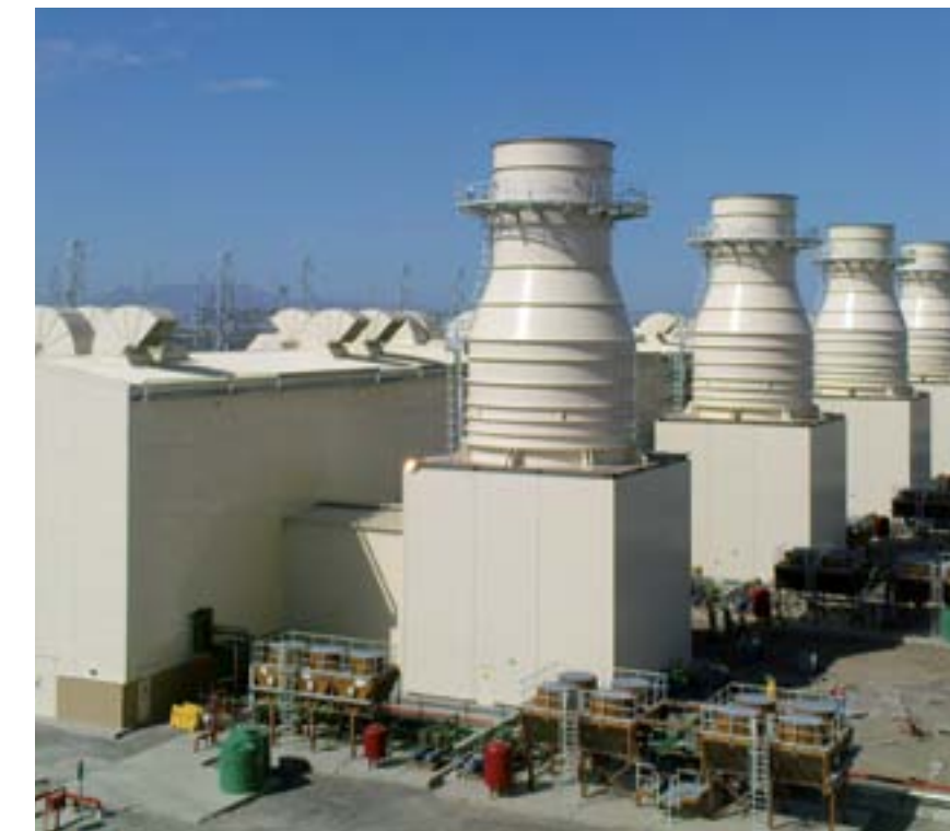
Photo à gauche: Capotage insonorisant d'une turbine à gaz GT13, outdoor, Alstom AG; projet Colongra, Australie Photo à droite: Capotage pour turbines à gaz; Roshcon, projet Ankerlig
