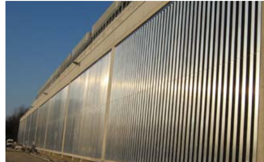
Photo ci dessus: silencieux dissipatif pour tours de refroidissement, GEA Energietechnik GmbH, projet Mellach, Autriche
