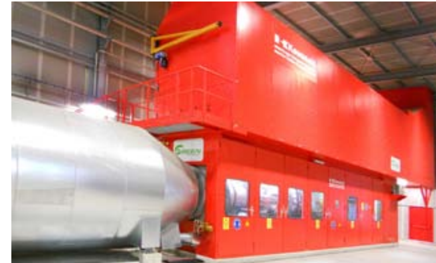
Photo du bas: Encoffrement insonorisant de compresseurs; Linde AG; projet Pearl, Qatar
