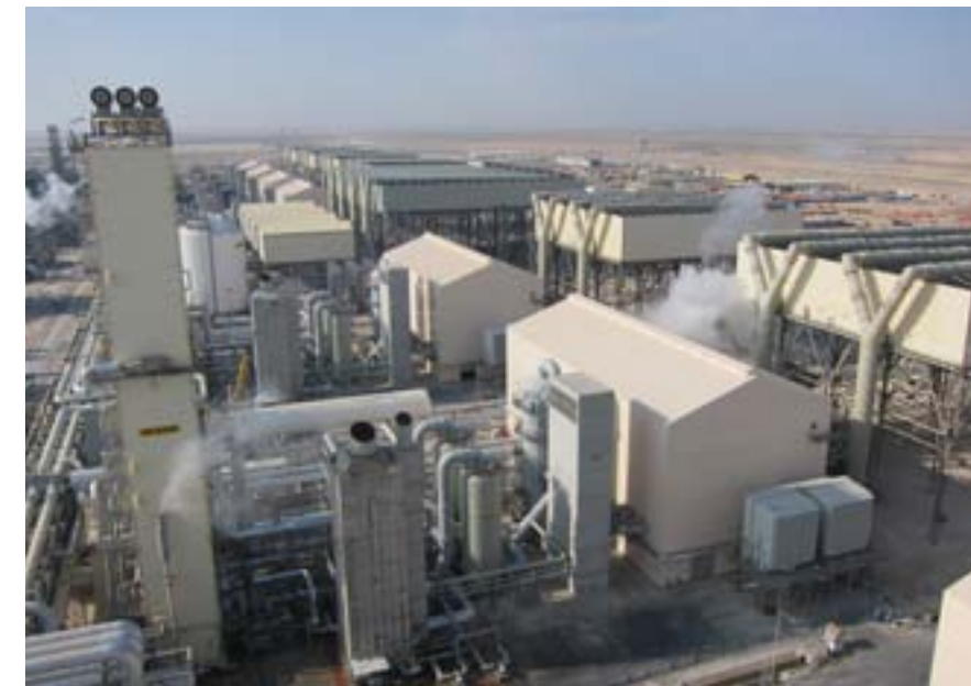
Photo du bas: Encoffrement insonorisant de compresseurs; Linde AG; projet Pearl, Qatar
