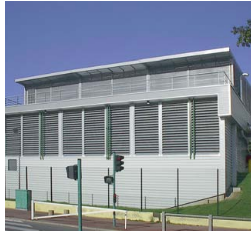
Concept global d'insonorisation d'une installation de cogénération; Wärtsilä Power Plants; projet Aulnay-sous-Bois, France
