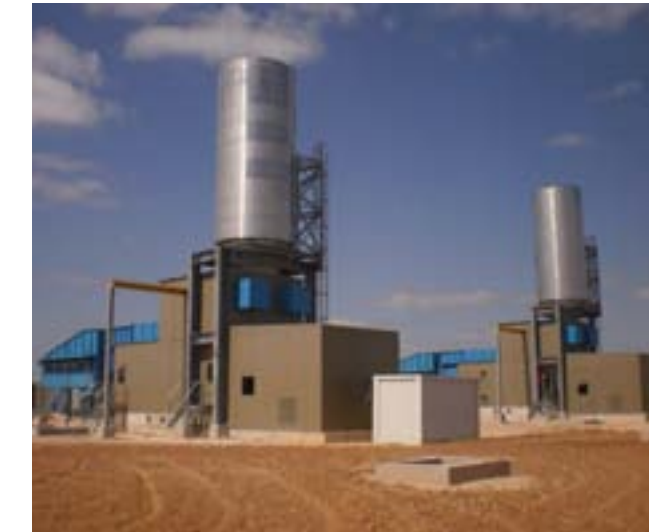
Photo ci dessus: encoffrement (capot insonorisant) pour turbine à gaz THM, MAN Diesel & Turbo SE, projet Villarpipe, Espagne
