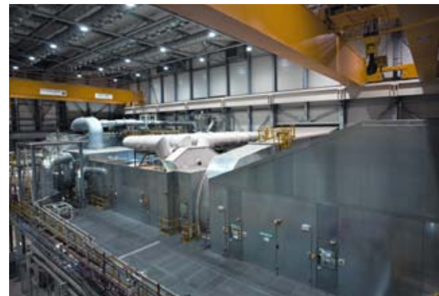
Photo du haut (ci-dessus): Vue dans le compartiment de filtration d'un package GPB80 de KAWASAKI Gas Turbine.
