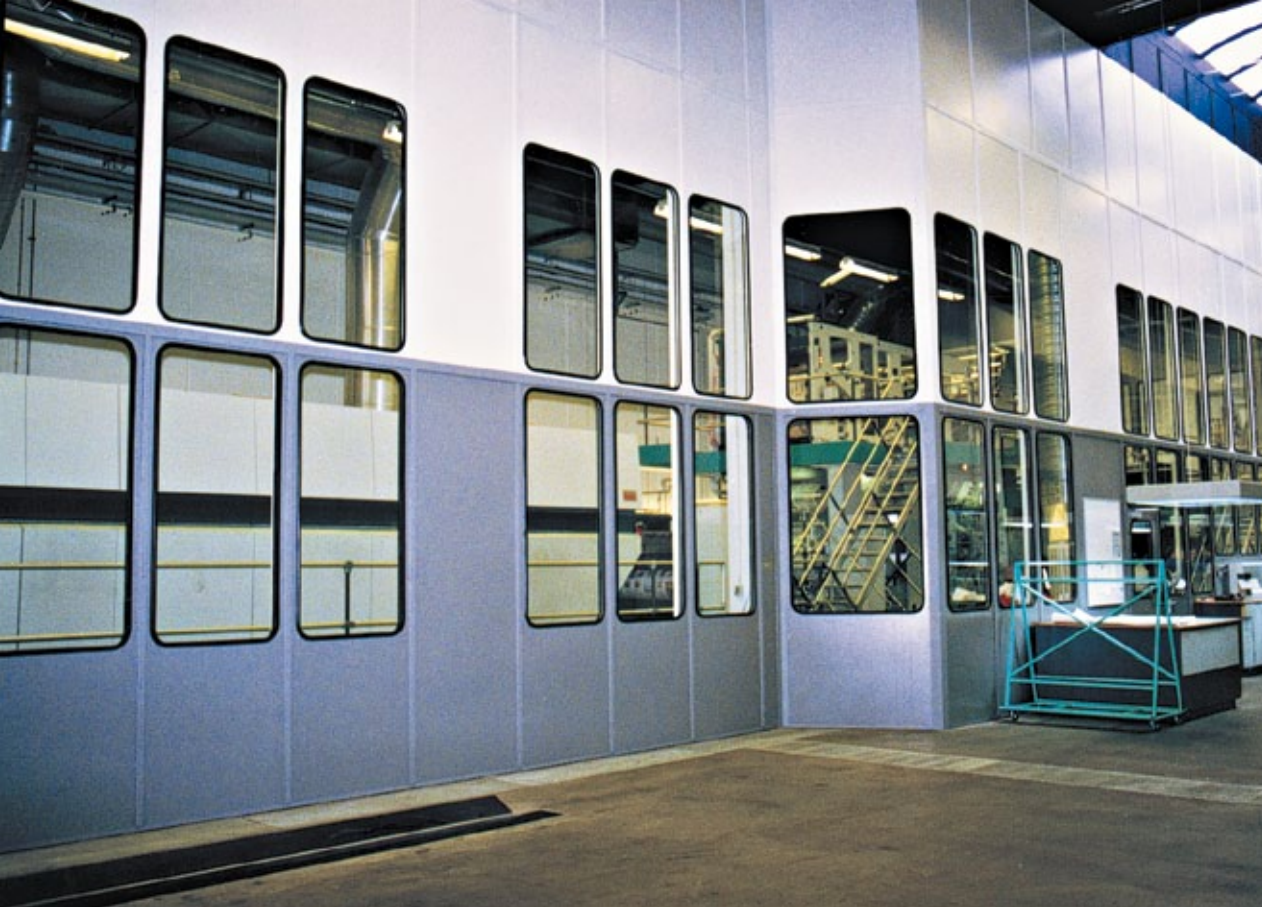
Cloison acoustique pour une rotative d'imprimerie de labeur. Affaiblissement acoustique 25 dB, Stibo Graphic, DK-Horsens
