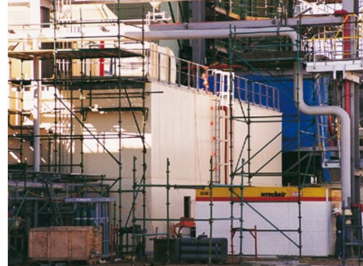
Encoffrement d'une turbine à gaz ; Alstom AG, AU-Pelican Point
