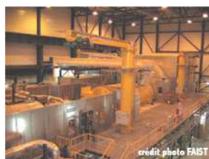
encoffrement d'une turbine à vapeur et écran pour générateur (indoor)
