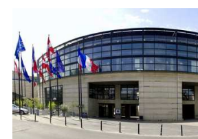
ITS intervient vis-à-vis de la qualité des constructions pour le respect de la réglementation en matière de confort acoustique (ci-dessus: bâtiment tertiaire)
