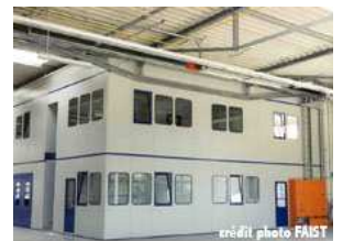
bureaux d'atelier insonorisés sur 2 niveaux (industrie mécanique)
