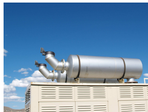
silencieux d'échappement pour moteurs thermiques
