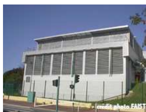
bâtiment insonorisant pour une centrale de cogénération
