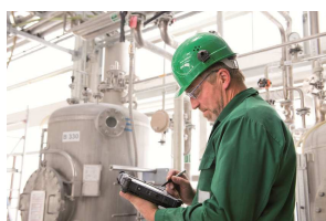
Le diagnostic sur site (ci-dessus: en milieu industriel) est souvent une étape importante d'une démarche de lutte contre le bruit
