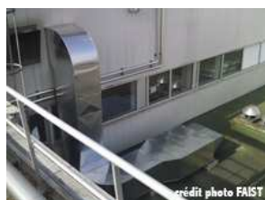
doublage d'une gaine d'extraction d'air (industrie pharmaceutique)
