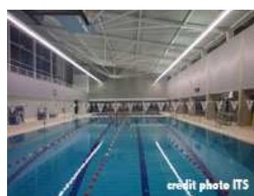
revêtement absorbant pour réduction de la réverbération d'un local à usage sportif
