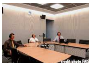
revêtement absorbant pour une salle de jury d'écoute (industrie automobile)
