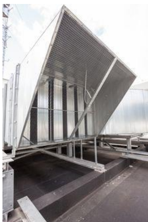
Figure 0 silencieux à baffles de section rectangulaire, avec protection contre la pluie
